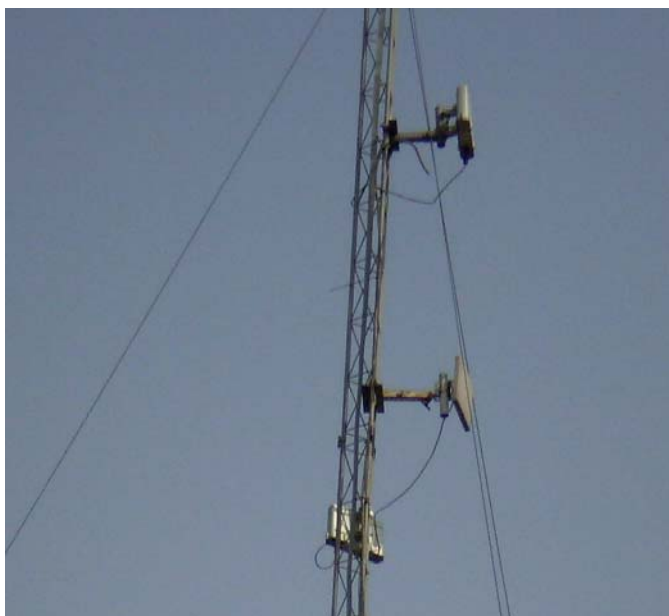
Figure 1. L'installation sur le toit
