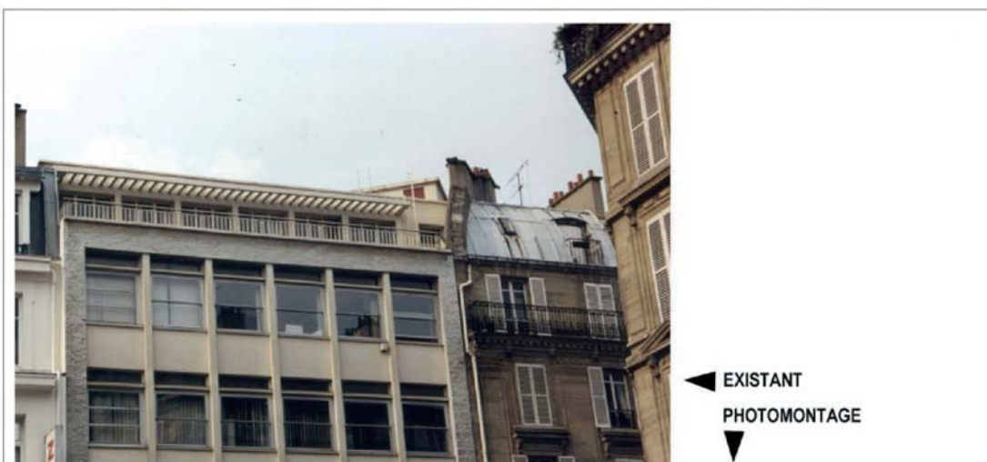
Vue de l'emplacement de près
